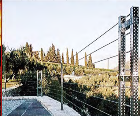
Rambarde en acier INOX sur mur en pierre
