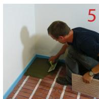
5 Enrober le Warmup MAT à l'aide de mortier colle flexible (C2S1 ET) ou de ragréage fibré compatible PRE
