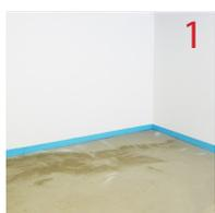
1 Le support doit être nivelé et dépourvu de poussière.
