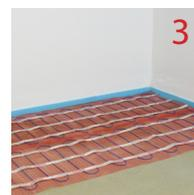
3 Dérouler le système en le découpant avec précaution si nécessaire.
