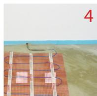
4 Veiller à bien placer la liaison froide de façon à la connecter ultérieurement au thermostat.
