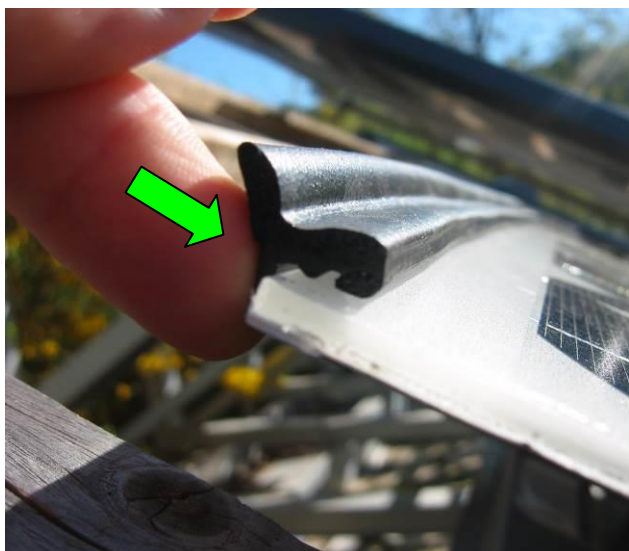
Plaquer le fond de pince du joint contre l'arête du module
