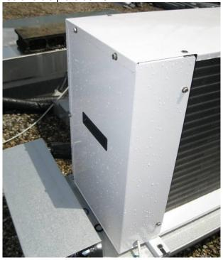
Le coffret de raccordement se trouve derrière le capot :
