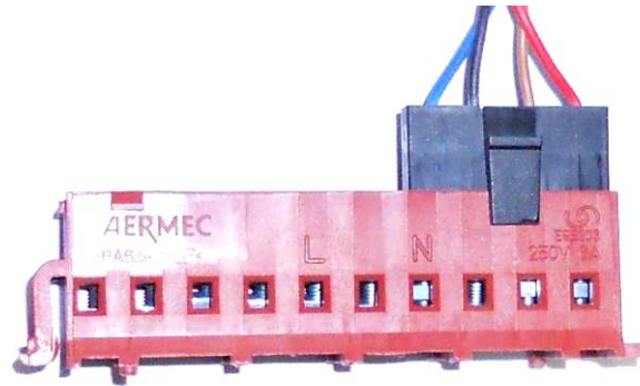
Bornier électrique du ventilo-convecteur Aermec FCX
